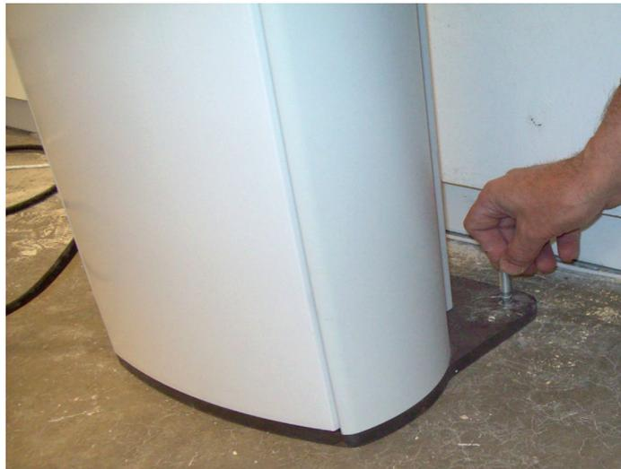
5. Die Ankerschrauben mit einem 14-mm-Steckschlüssel (9/16 Zoll) anziehen. Bei Holzboden die Ankerschrauben mit einem 14-mm-Steckschlüssel (9/16 Zoll) anziehen (gleiche Steckschlüsselgröße wie bei Zementboden).
